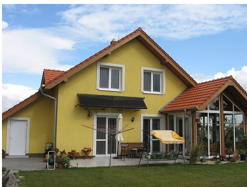
2 kolektory v zostave TS 330 – maximálna výška dotácie je 1213,-Eur.
